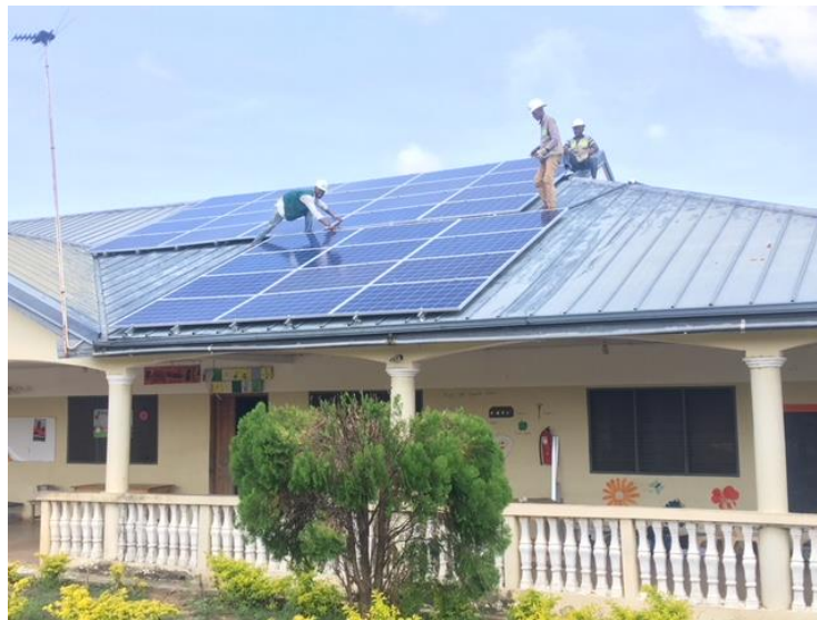
Eerste fase project zonne energie
